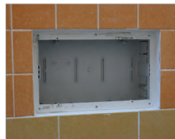
Le viti in acciaio imperdibili funzionano da estrattori del coperchio Not losing screws act as extractor cover Les vis imperdibles travaillent par l'extraction du couvercle
