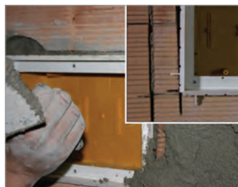
Profondità ridotta per utilizzo anche in muri da 10 cm Reduced depth for use on 10 cm walls Profondeur réduite pour utilisation dans une paroi de 10 cm
